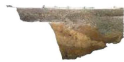
トレンチ⑦ 南壁断面(東側)
