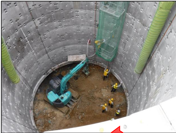
杭（深礎工法）写真
