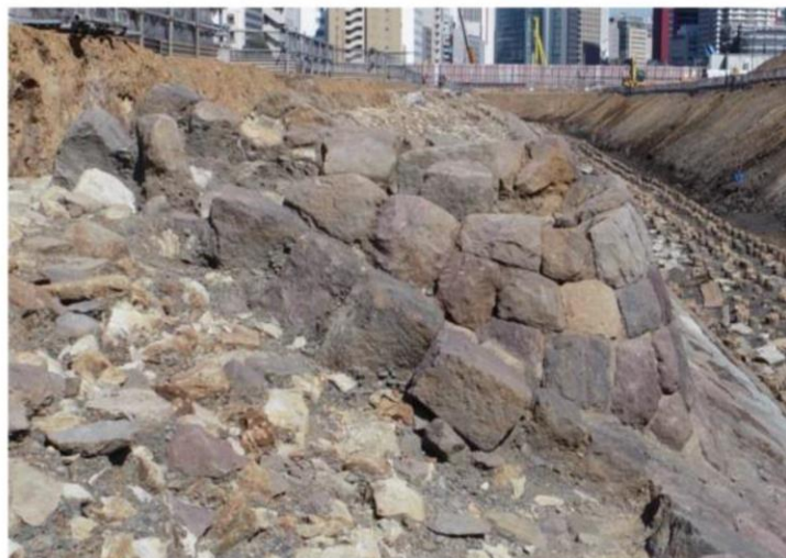
4街区信号機土台部 南側側面
