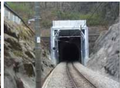
覆い工 [ トンネル出入口 ]
