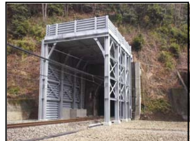
覆い工 〔 トンネル出入口 〕
