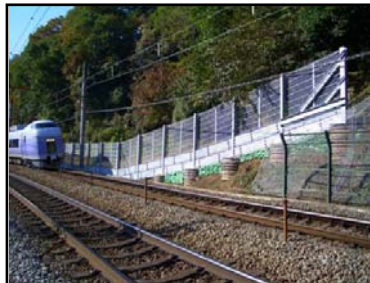
土砂止め柵 〔 自然斜面 〕
