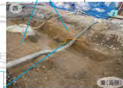
築堤盛土確認状況
