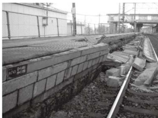
図1 組積式擁壁を有する盛土式乗降場の被災例
