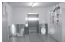
物流用エレベーター
