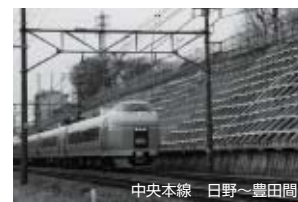
切取りの面工 (吹付砕工)
