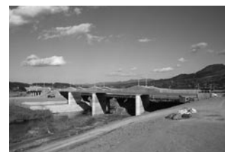
東北線平泉～前沢間衣川橋りょう
