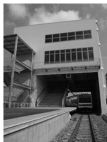
Smart Station 実験棟
