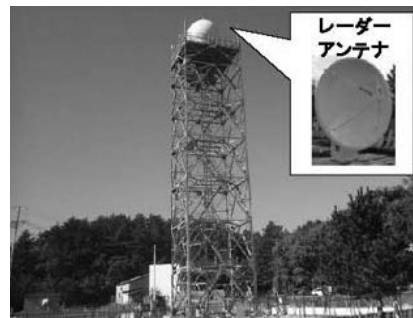
ドブラーレーダーを用いた突風に対する列車運転規制の開始と突風の探知精度向上
