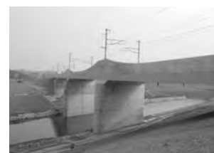
東北線平泉～前沢間衣川橋りょう
