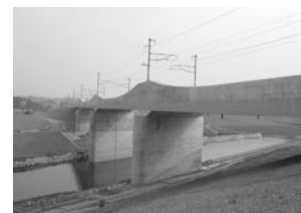
東北線平泉～前沢間衣川橋りょう
