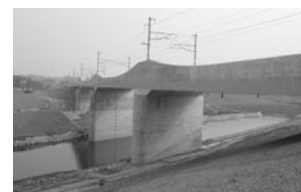
東北線平泉～前沢間衣川橋りょう
