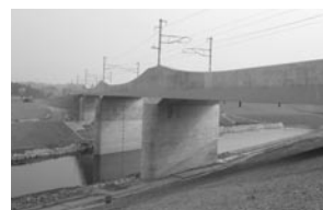
東北線平泉～前沢間衣川橋りょう
