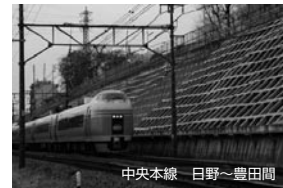
切取りの面工(吹付砕工)
