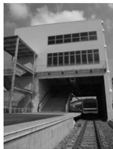
Smart Station 実験棟
