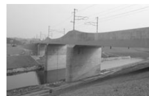
東北線平泉～前沢間衣川橋りょう
