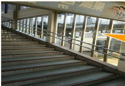
階段の吹き抜け部分に雨よけのクリアガードを設置し雨で濡れないようになりました。
