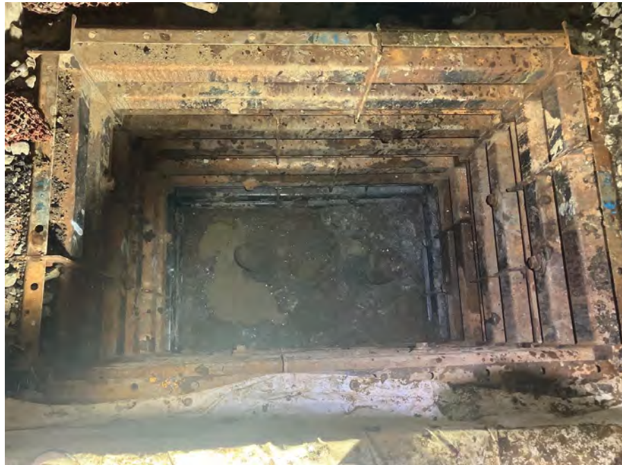
KP26-4 松杭検出状況
