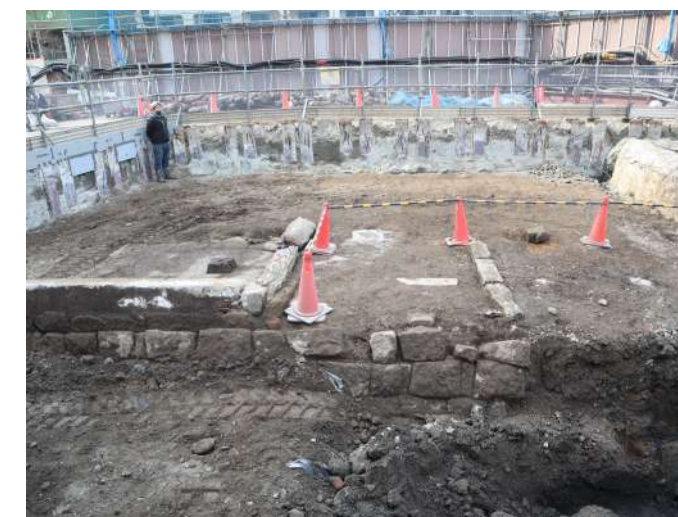
⑥石積み護岸と建物基礎跡
