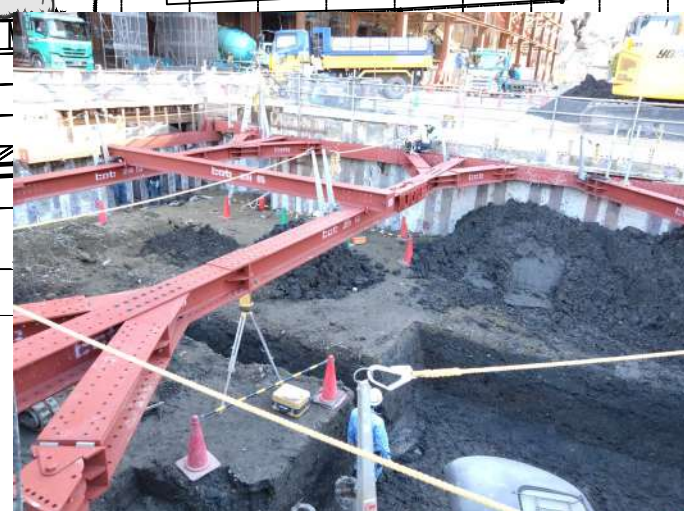
③埋め立て土掘削状況
