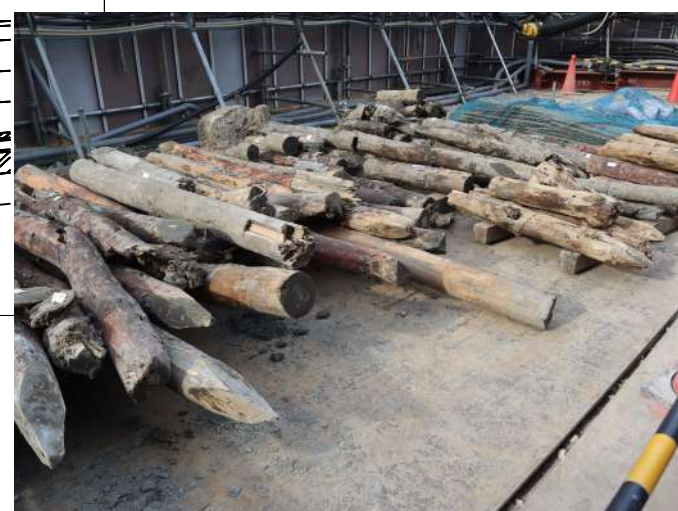
⑤撤去された土留め列の構材材
