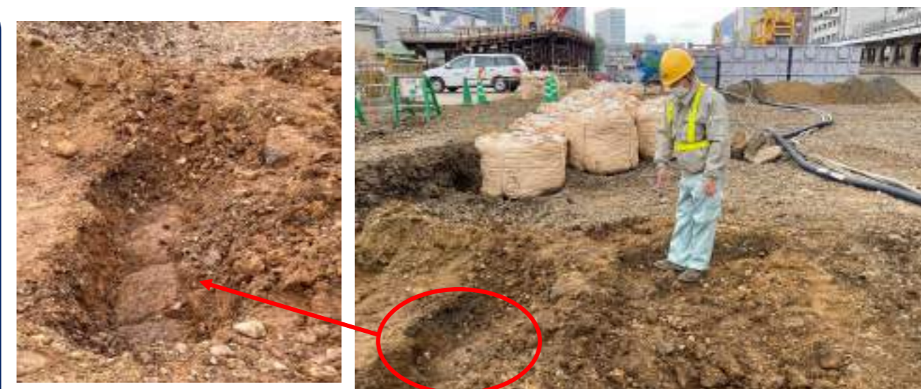
図1 仮ベント部西側開業期海側石垣検出状況（東京都教育庁 撮影）
