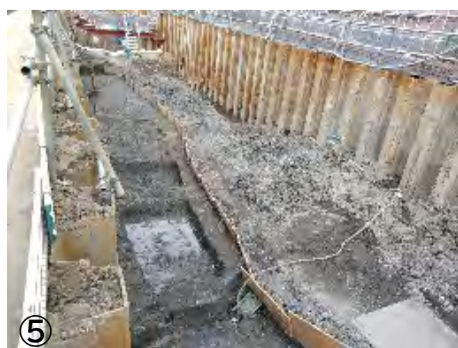
①硬質粘土層上面での遺構検出状況(南東から) ②同(南東から) ③遺構完掘状況(東から) ④同(南東から) ⑤同(北東から)
