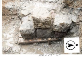
⑥水路石垣 (追加分) 検出状況 1 (2023. 3. 27)
