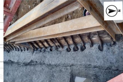
④ピット掘削後
