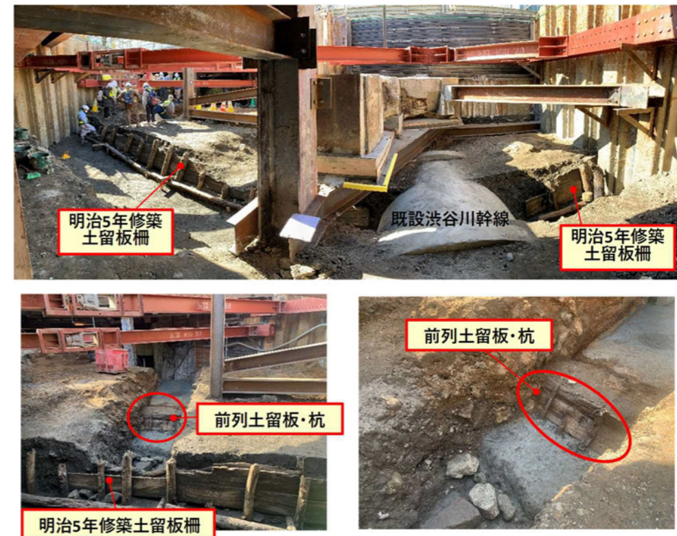
写真-1 国道側護岸遺構の出土状況
