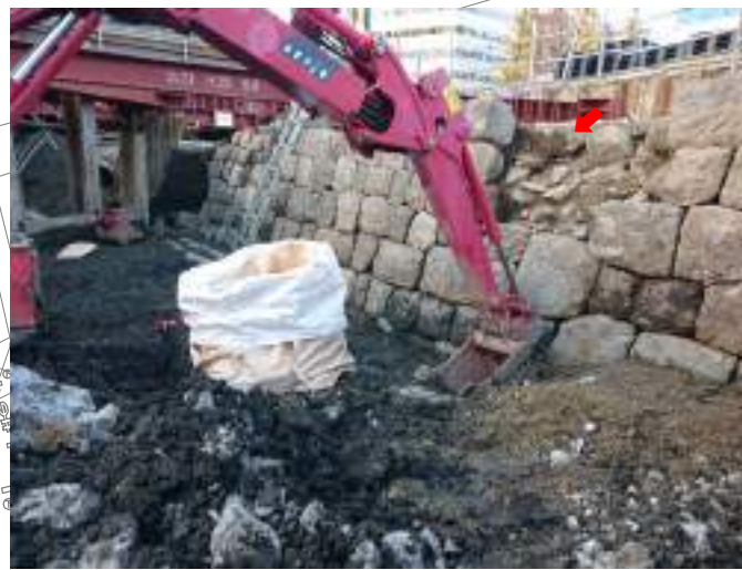
②石垣検出状況・1(2022.12.24)
