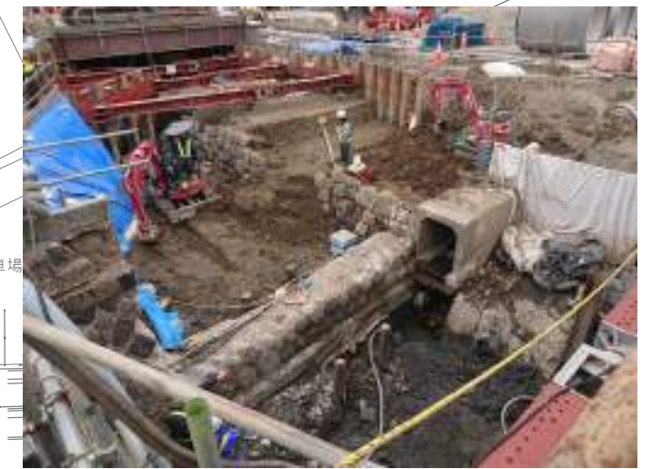
④石垣検出状況・3(2022.12.21)
