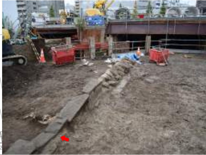
①裏込め石検出状況(2022.11.30)
