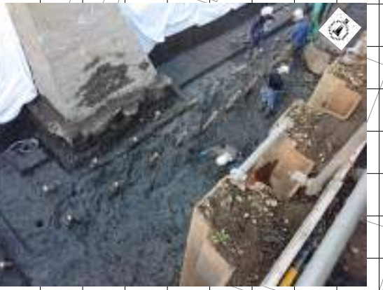
粘土採掘坑B完掘状況
