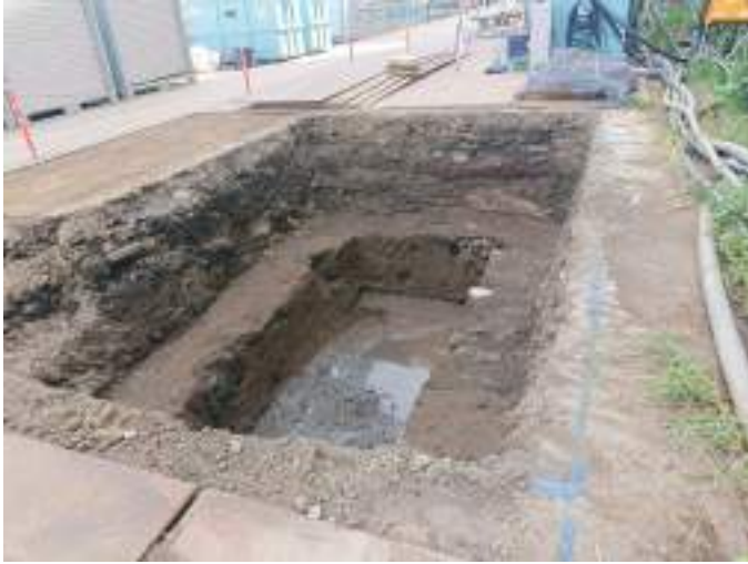
試掘坑A (北西から)
