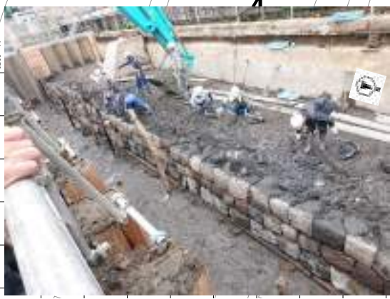
b区石垣検出状況
