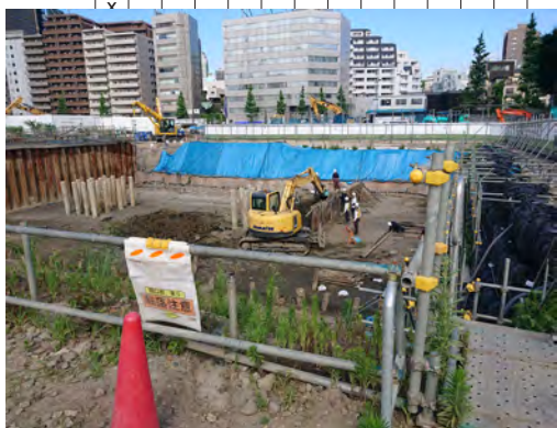
②北横仕切堤調査状況 1
