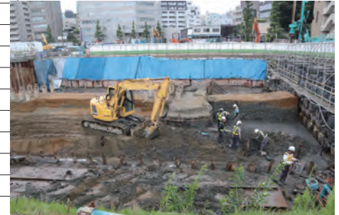
⑤E-2・F区縦断面確認状況1
