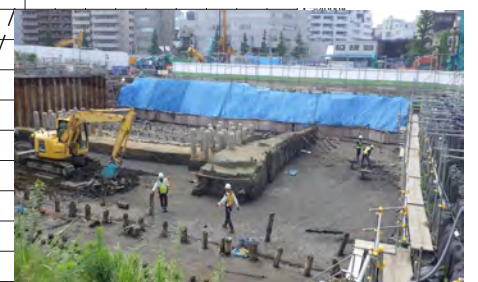
⑥E-2・F区縦断面確認状況2
