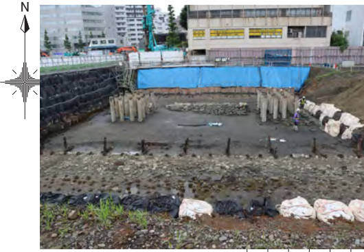
D ①D区土丹検出状況1
