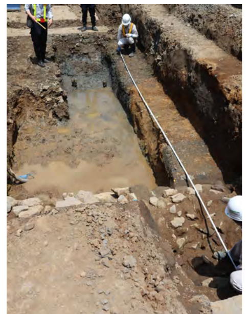
⑦計測状況
