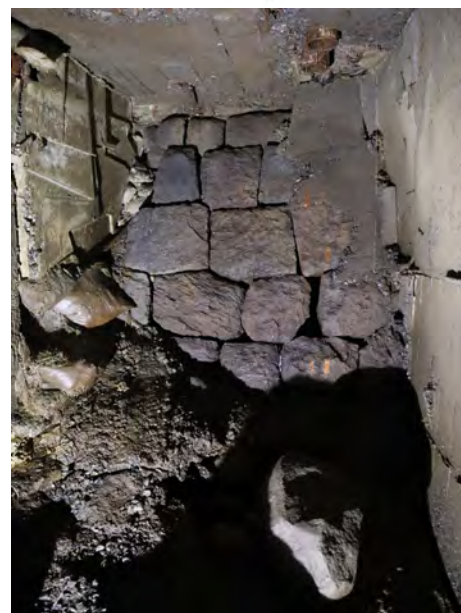
①暗渠内石積み
