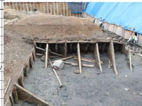
④北横仕切堤北面土留め
