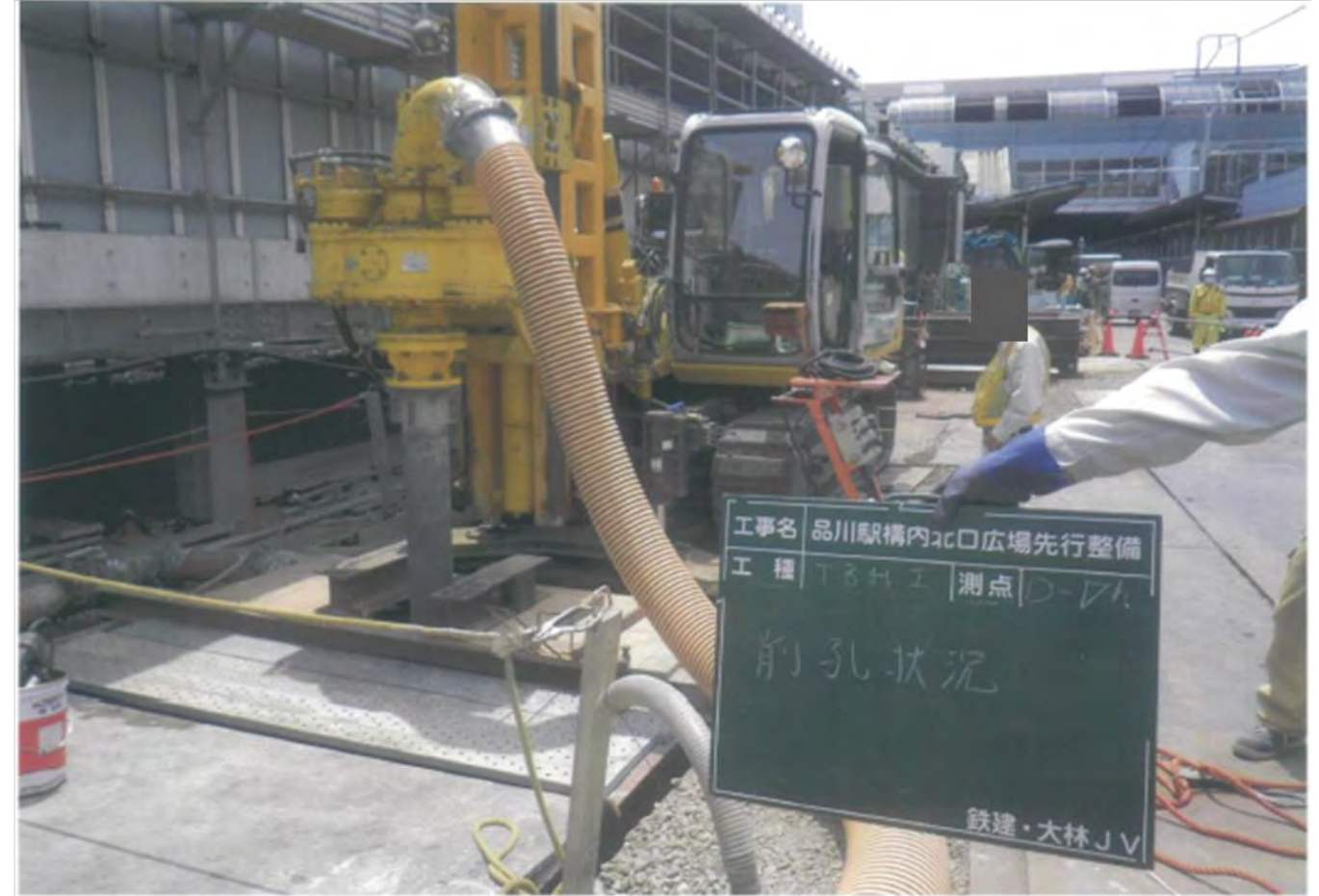
⑥ 箇所：TBH工法
