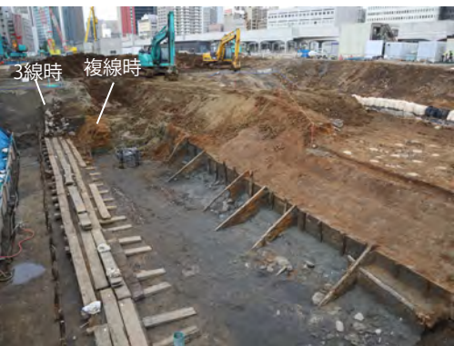
①D区山側調査状況
