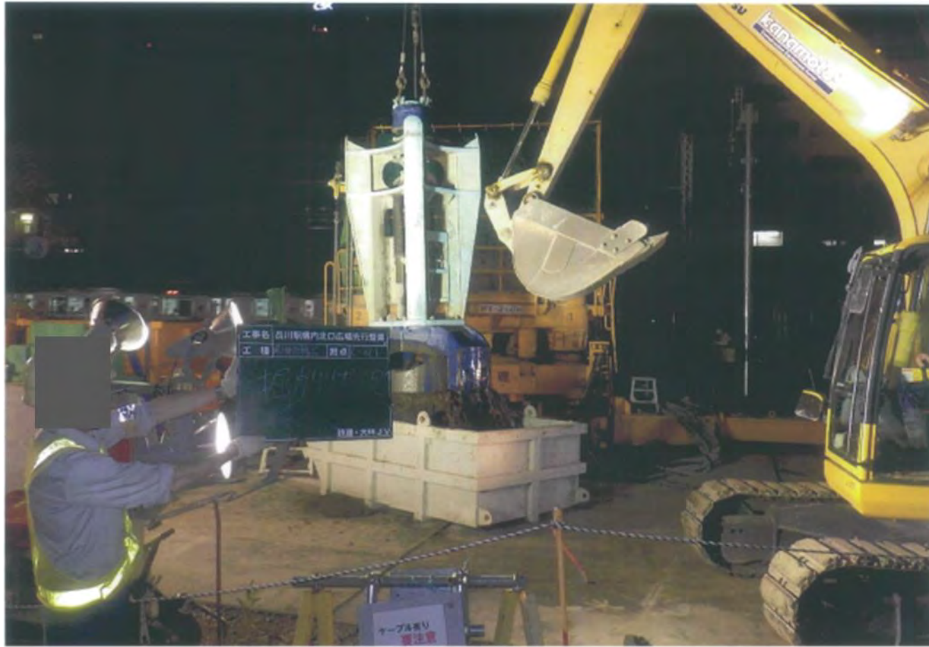
⑤ 箇所：オールケーシング工法
