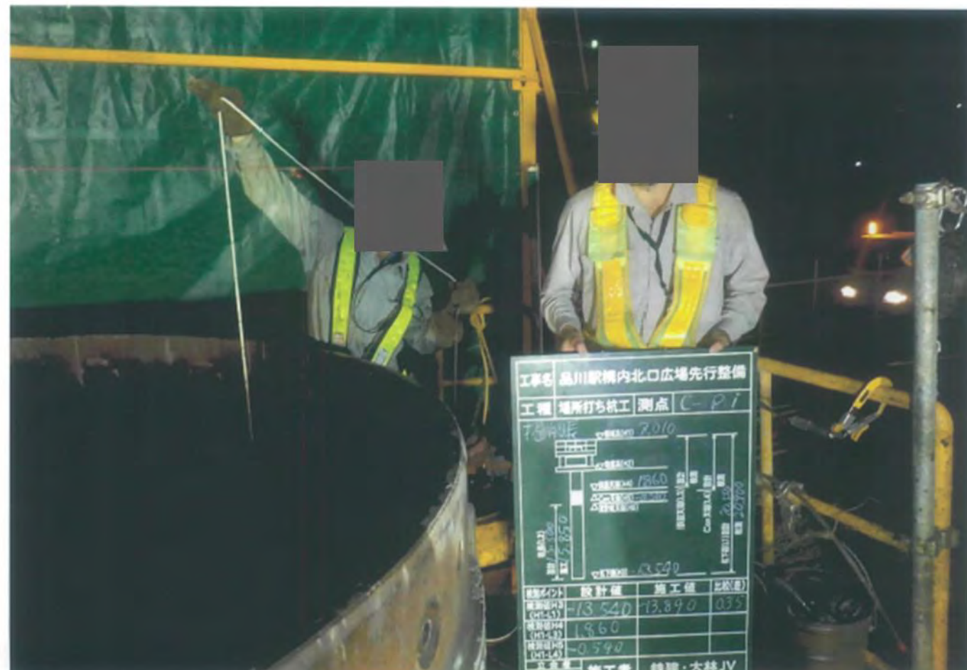
④箇所：オールケーシング工法
