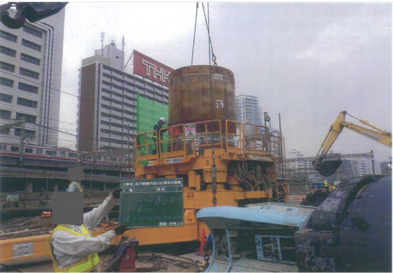
③箇所：オールケーシング工法
