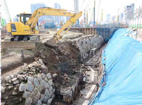
③E-2区張り出し部裁ち割り調査状況
