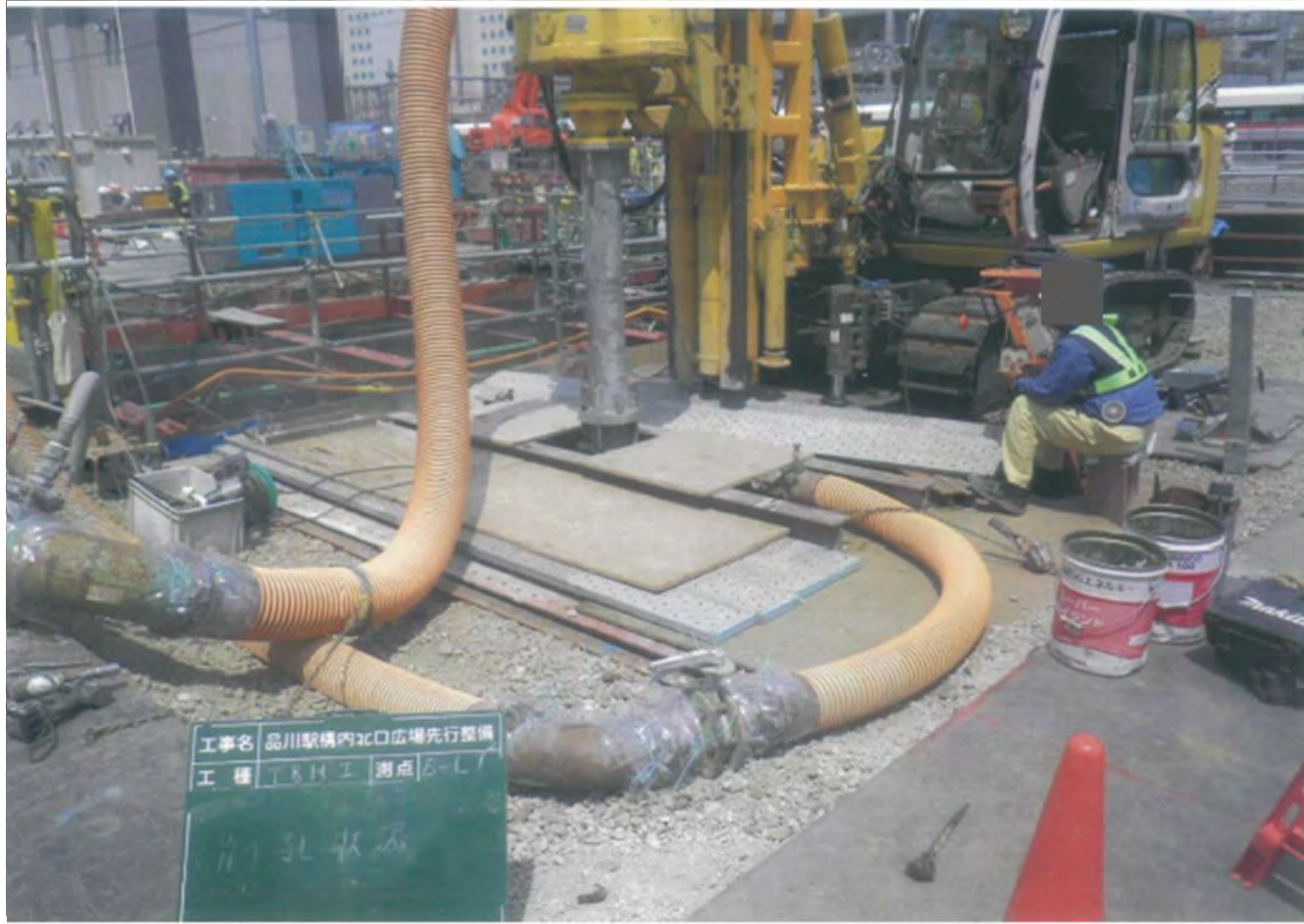
①箇所：TBH工法
