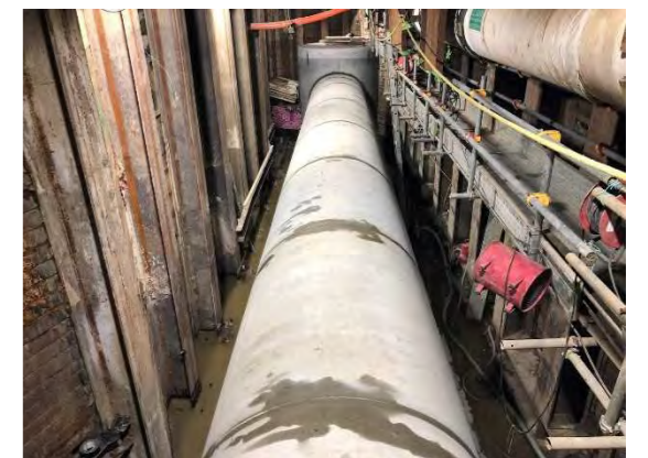
写真-1 高輪幹線管布設完了(国道部)
