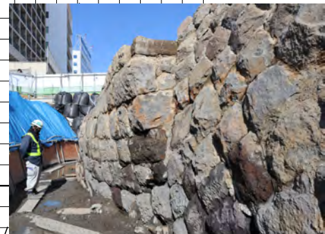
④E区山側3線化時石垣検出状況
