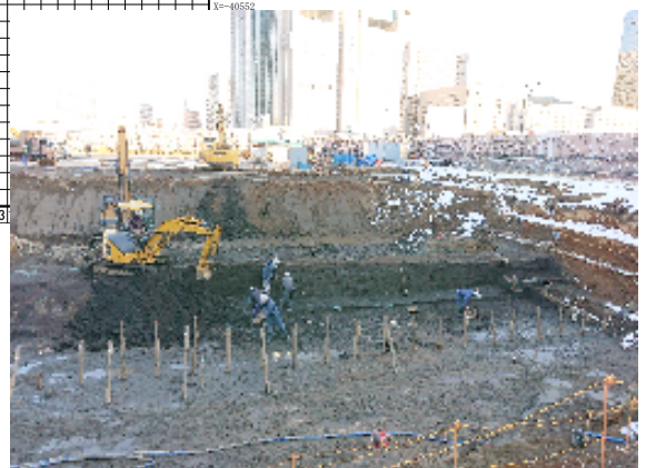
⑤ I 区芯材掘削状況
