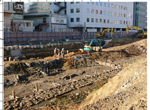
①B・C区裏込め石下調査状況
