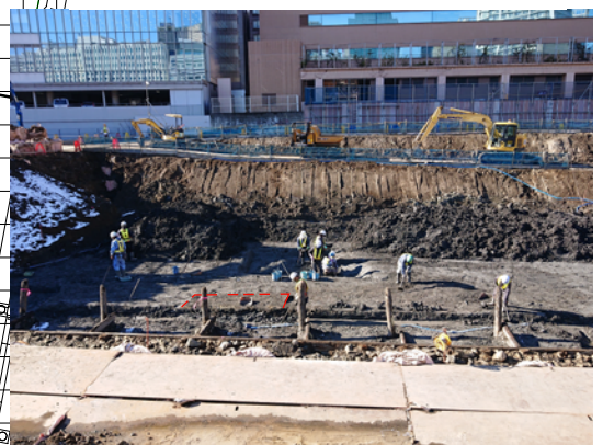
②B区遺構検出検出状況 (築堤構築以前)
