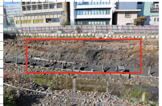
①B・C区裏込め石下調査状況
