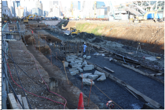
④ G区築堤内石垣廃棄状況
