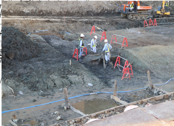
②B区芯材裁ち割り調査
