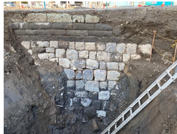
北横仕切堤（南面）
