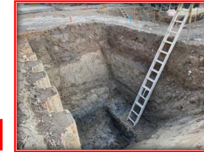
トレンチ2 北横仕切堤 北面 (石積無し)
