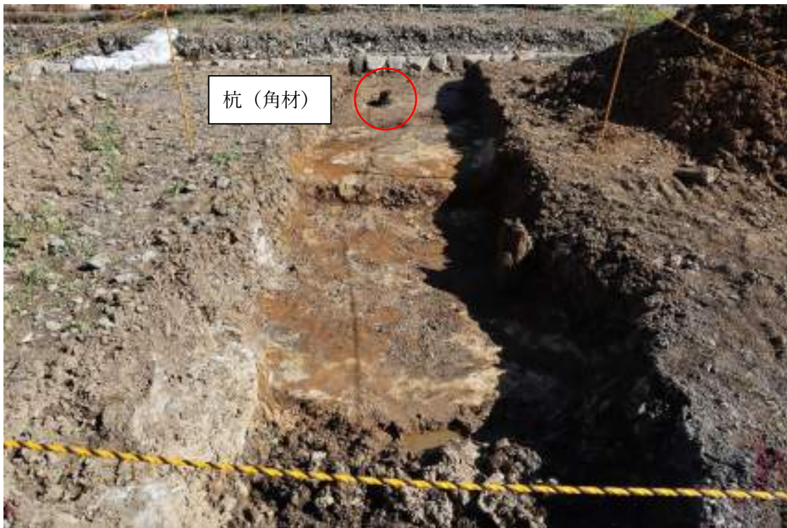
トレンチ 1 全景（西から）
