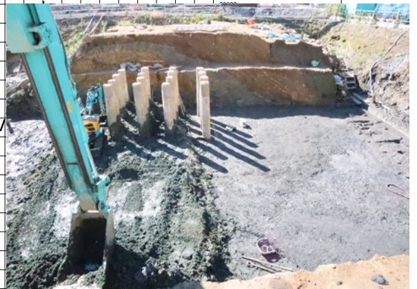
③ 2E区自然堆積層検出状況
