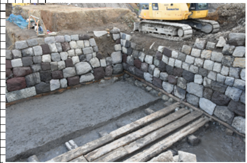
②南横仕切り堤?洞木部分
