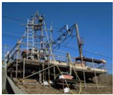
ボーリング施工状況
