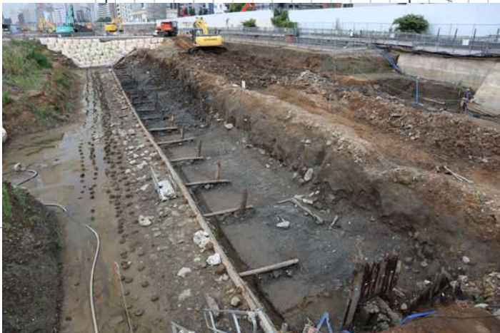
②3-A ~ C 区海側石垣撤去状況
