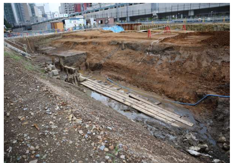
②1-A区バラスト下掘削状況
