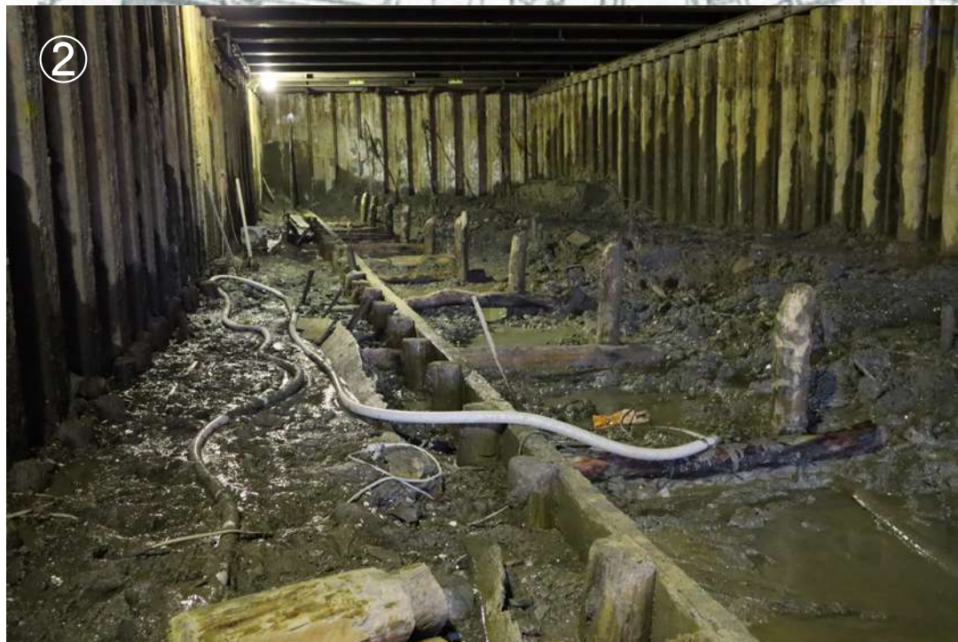
② 仮斜路部石垣撤去状況
