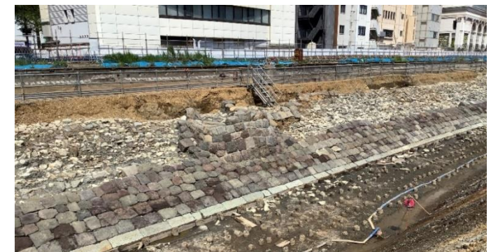
信号機土台部の様子
