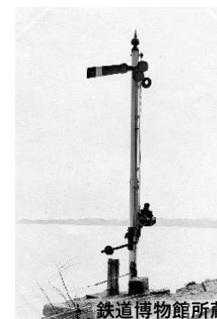
明治30年代に高輪築堤に設置されていた信号機
