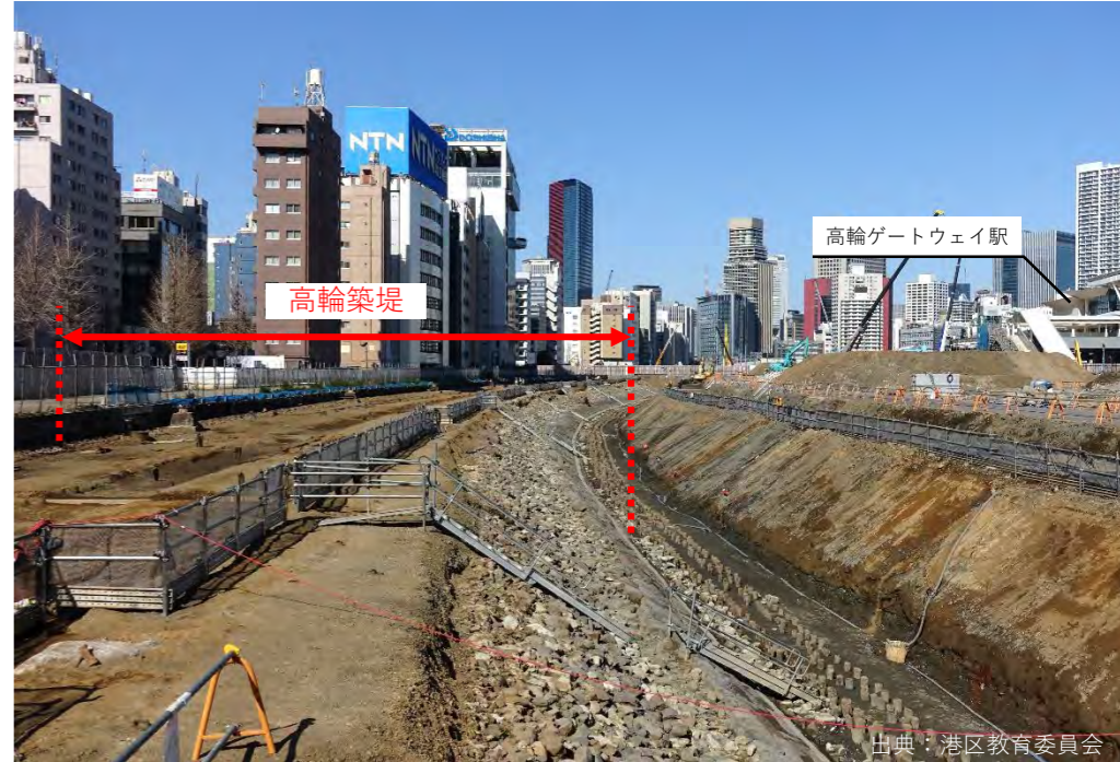
4街区南部より田町方面を望む 築堤が円弧上に湾曲している様子が確認できる
