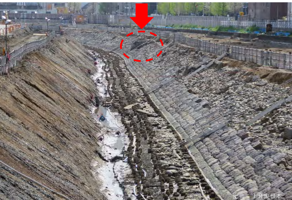
4街区北部から南部を望む 築堤が湾曲し始める部分に信号機跡（赤い矢印部分）が見える
