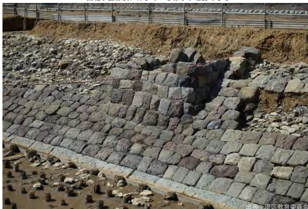
信号機跡と推定される張り出し部分
