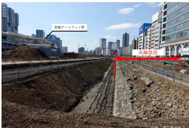
4街区北部より南部（品川方面）を望む 築堤が直線状に伸びている様子が確認できる
