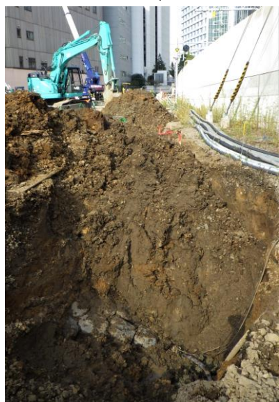
①海側石垣検出状況
