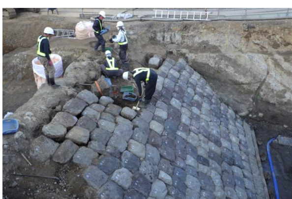
⑤海側石垣撤去作業
