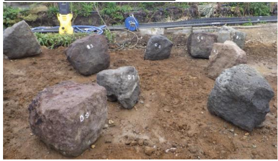
④撤去した石垣
