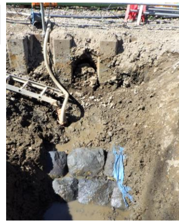
⑨仮斜路部海側石垣検出状況
