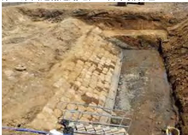
3街区 第7橋台北側 海手側石垣
