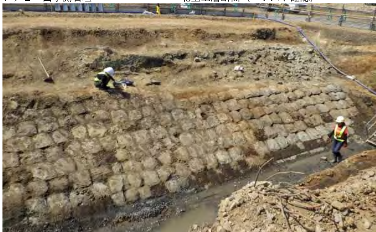
2街区築堤残存確認調査 海手側石垣
