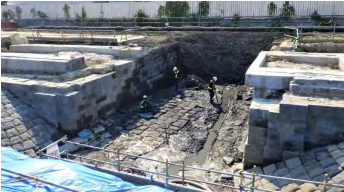
3街区 第7橋台 海手側
