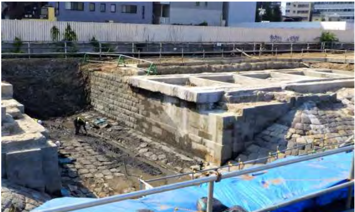
3街区 第7橋台 北側橋台全景
