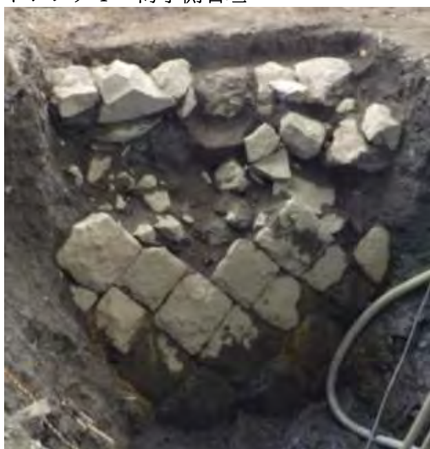
トレンチ 2 山手側石垣
