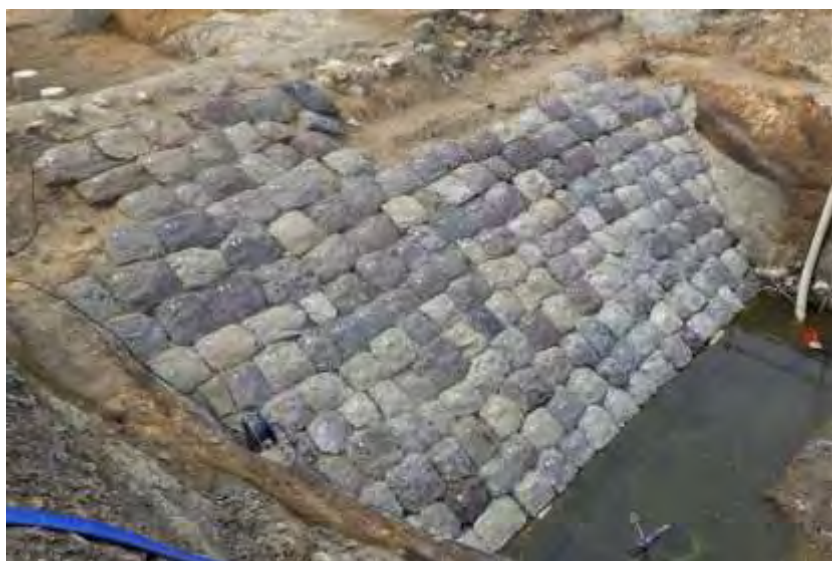
第2東西連絡道路地区 海手側石垣
