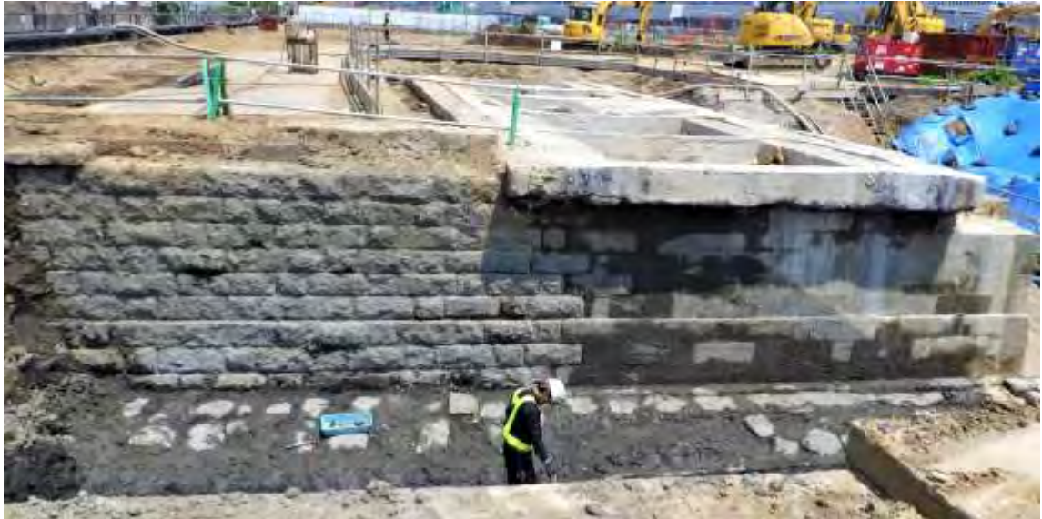
3街区 第7橋台 北側橋台（右手初期橋台、左手山手側橋台拡張）
