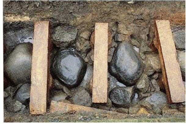
図 2-5-13 : 駅舎の基礎構造
