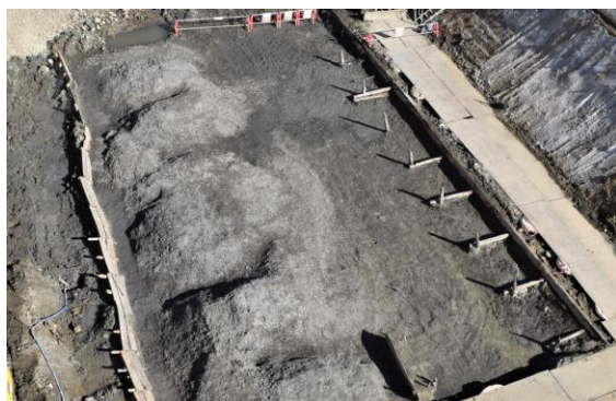
図2-5-32：マウンド状に盛土を連ねた築堤の芯（1街区）
