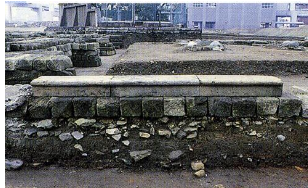
図 2-5-15 : 駅舎の入口部の 1 段目のステップ
