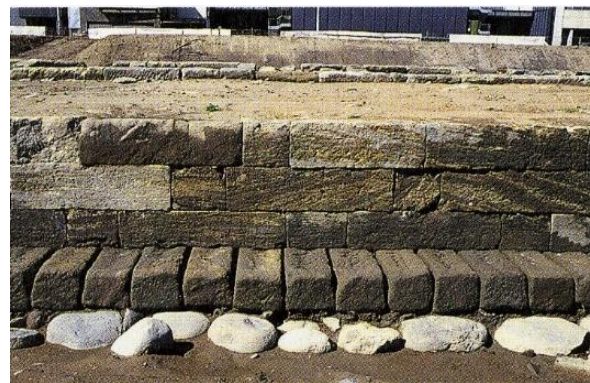
図 2-5-17 : プラットホームの基礎石積
