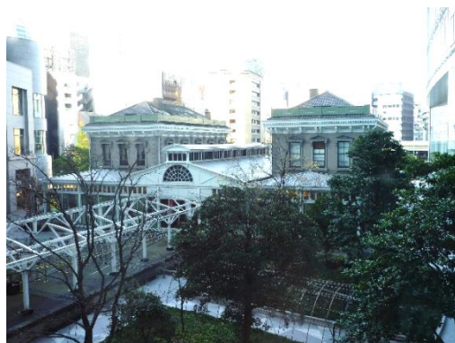
図 2-6-6 : 新橋停車場復原駅舎 ホーム側
