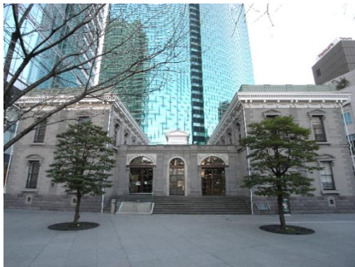
図 2-6-5 : 新橋停車場復原駅舎 入口側
