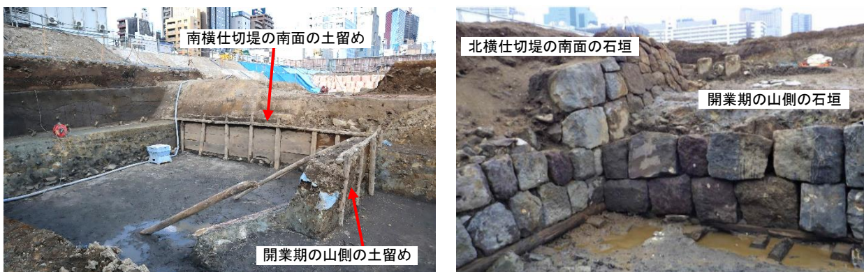
図2-5-44：築堤と仕切堤の接続部（2街区）
