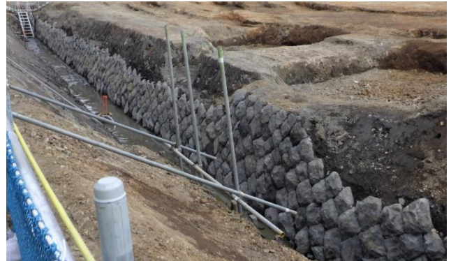
図 2-5-37 : 西側（山側：3 線拡張期）の石垣（1 街区）
