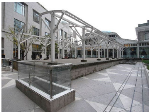
図 2-6-7 : 旧新橋停車場復原ホーム
