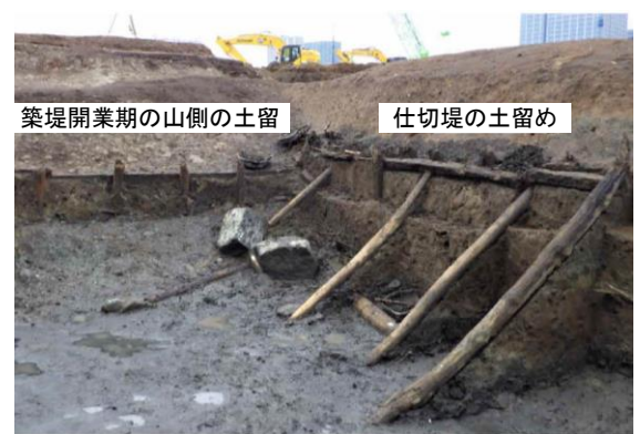
図 2-5-39 : 西側（山側：開業期）の土留め（2 街区）
