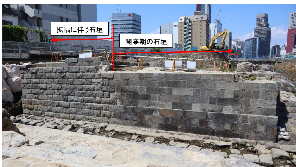
図 2-5-41 : 第 7 橋の橋台（北側）石面（3 街区）
