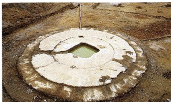
図2-5-22：機関車用転車台の基礎コンクリート
