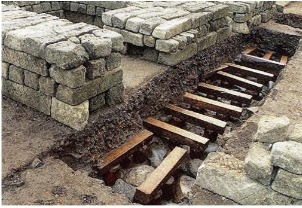
図 2-5-12 : 駅舎の基礎構造
