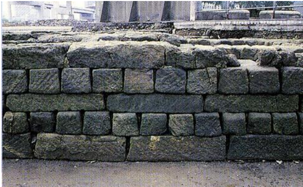
図 2-5-14 : 駅舎の基礎石積
