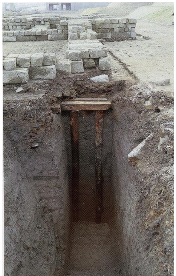
図 2-5-11：駅舎の基礎構造
