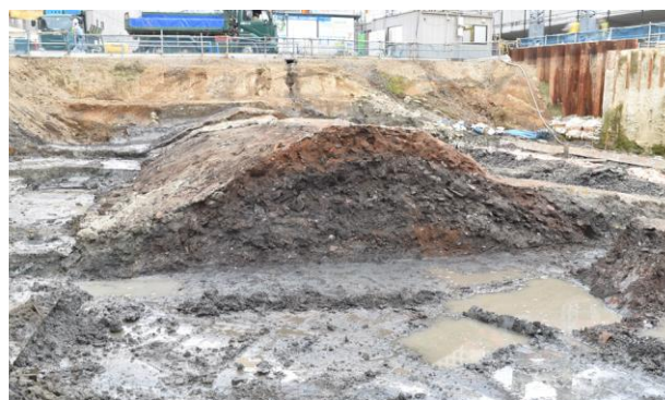
図2-5-33：蒲鉾形に盛土された築堤の芯（1街区）
