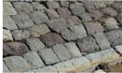
「高輪築堤」海側の傾斜した石積み
