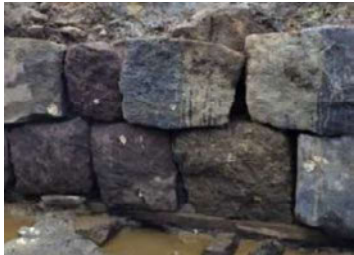
「高輪築堤」山側の垂直の石積み
