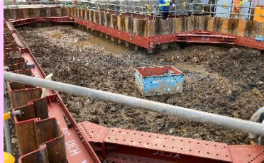
(b): 山留材設置中
