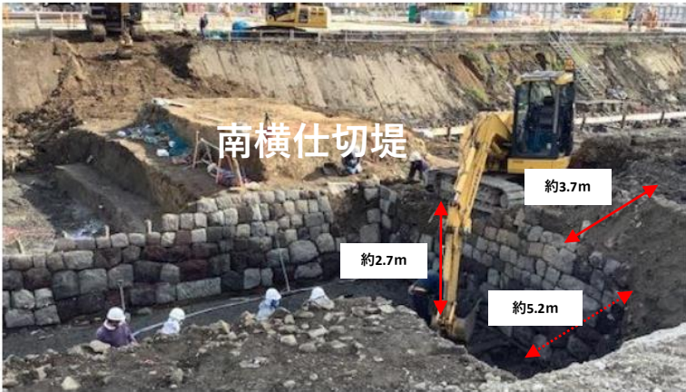
写真③ 南横仕切堤 北側
