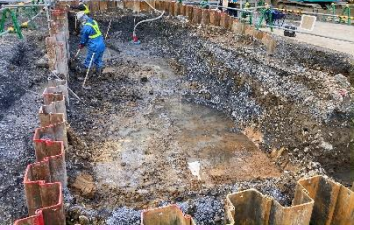
(c1): 1次掘削中
