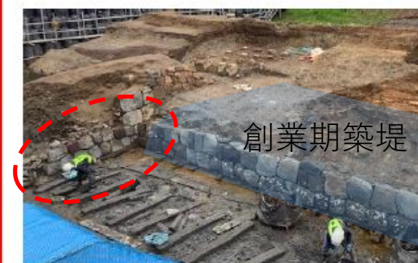
写真①：北横仕切堤石垣
