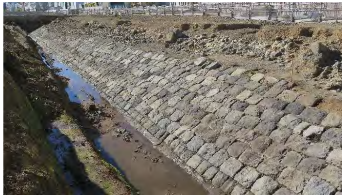
公園部の築堤
