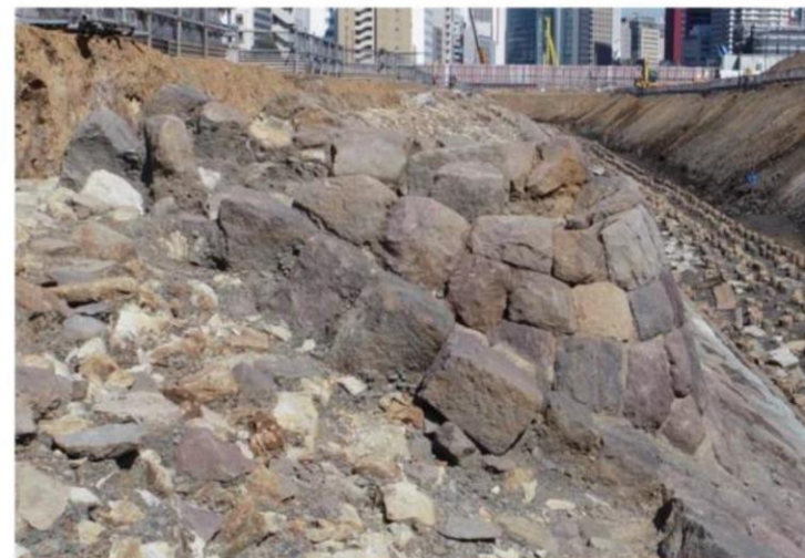
4街区信号機土台部 南側側面
