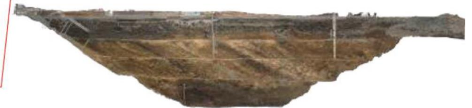
トレンチ② 南壁断面
