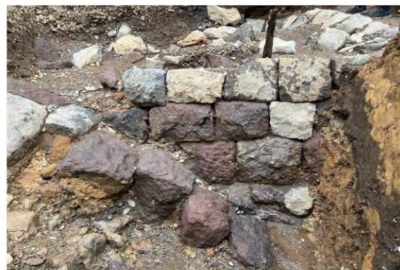
トレンチ7張り出し遺構 南側側面
