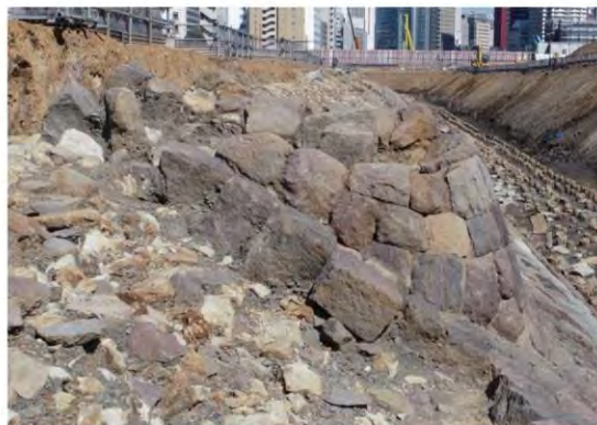
4街区信号機土台部 南側側面
