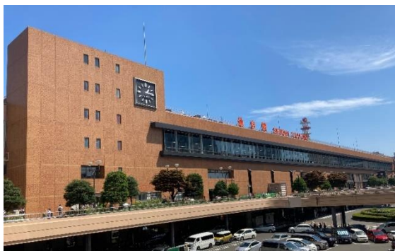
▲現在の仙台駅舎(西口より)
