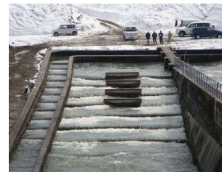
写真 2.2.6 非越流部設置での最大セイシュの発生状況
