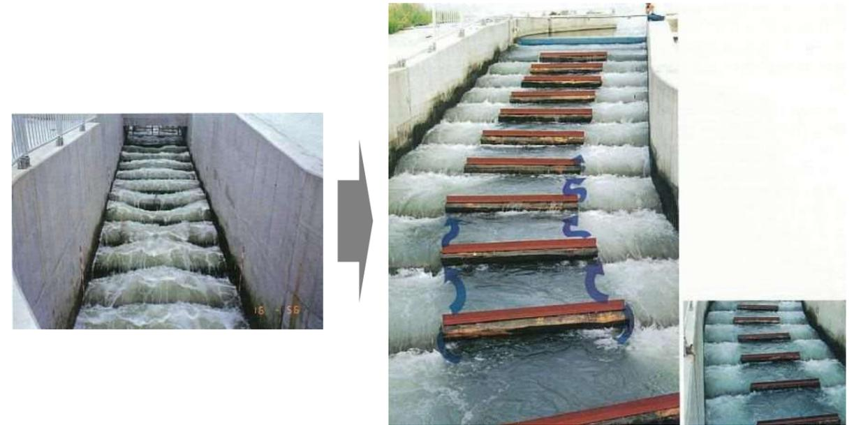
写真のおりに見事に横波が抑制されていますが、これは、両側に強い鉛直流が与えられた結果、セイシュが生じるために必要な側壁部分での水粒子の上下動が抑制されたためと考えられます。いわば宿命的にセイシュ発生の可能性を秘めているプールタイプの横波の発生を防ぐには、まだこれでは不十分なのですが、実用上はこれで十分に効果的であることが示されたわけです。
