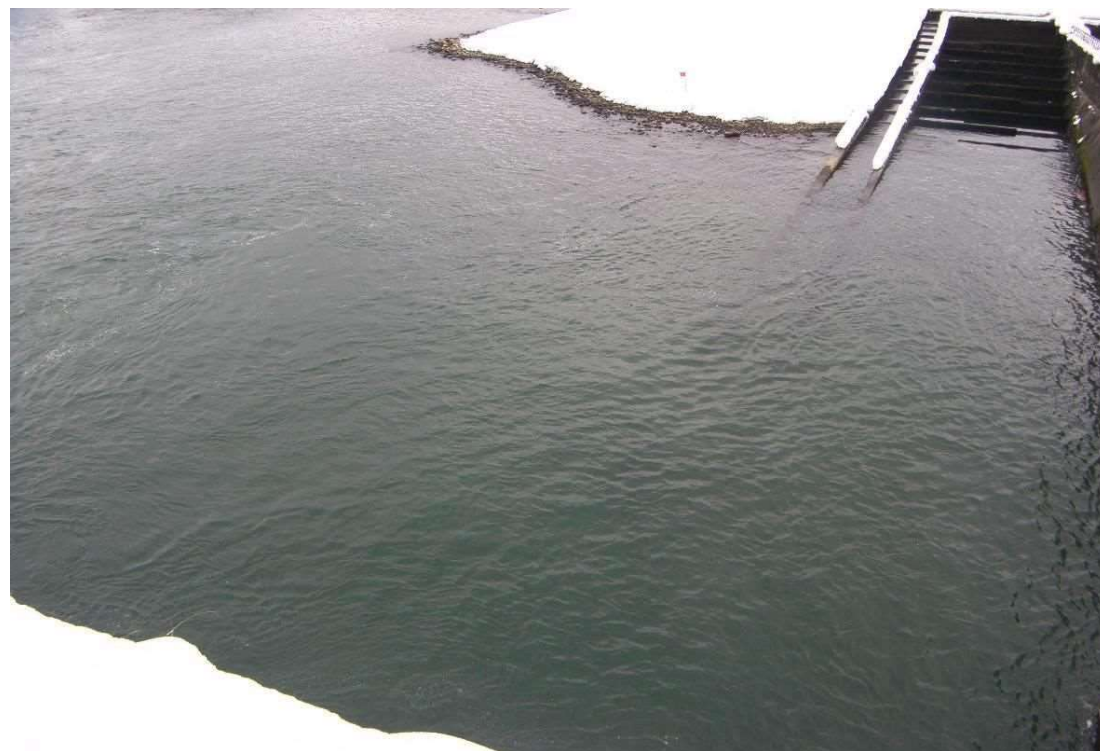
写真 1.1.10 魚道入り口付近の状況（ケース 1-3：魚道 0\text{m}^3/\text{s} 、呼び水 4.7\text{m}^3/\text{s} ）
