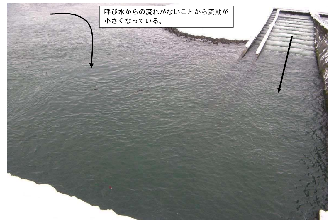
写真 1.1.9 魚道入り口付近の状況（ケース 1-2：魚道 4\text{m}^3/\text{s} 、呼び水 0\text{m}^3/\text{s} ）
