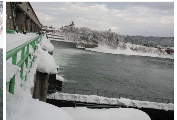
写真 1.1.5 管理橋右岸側から見た放流状況（ケース 1）
