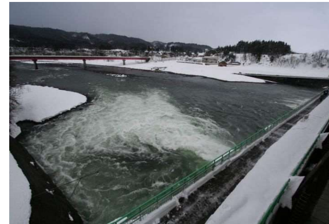
写真 1.1.13 管理橋左岸側から見た放流状況 (ケース 2)
