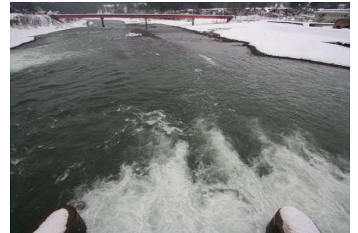
写真 1.1.14 6 番ゲートから見た放流状況 (ケース 2)
