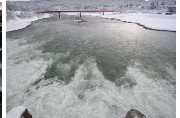
写真 1.1.7 6 番ゲートから見た放流状況（ケース 1）
