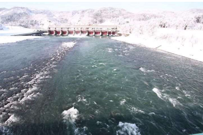
写真 1.1.1 宮中橋から宮中ダムを望む(操作規程放流)
