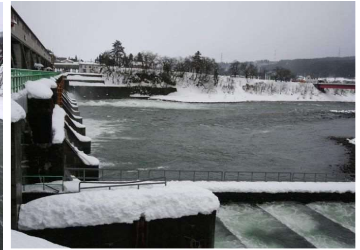
写真 1.1.12 管理橋右岸側から見た放流状況 (ケース 2)
