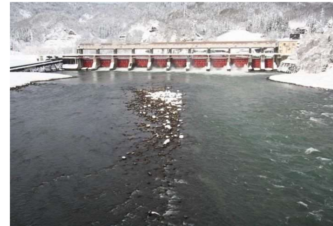
写真 1.1.4 宮中橋から宮中ダムを望む（ケース 1）
