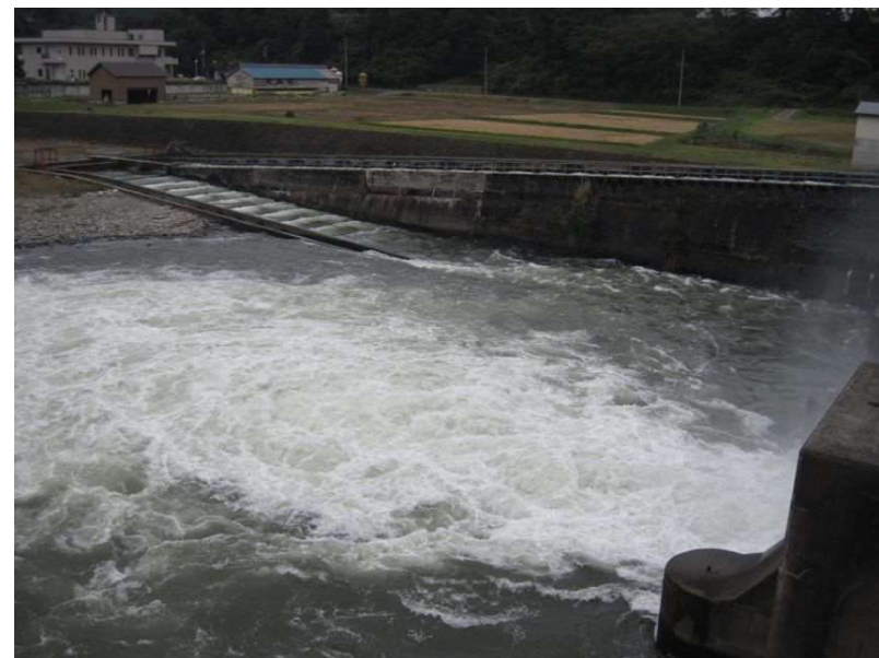
写真 1.1.18 管理橋より 10 番ゲートからの放流状況および魚道を望む(平成 21 年 10 月 6 日撮影)
