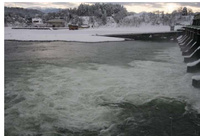
写真 1.1.6 管理橋左岸側から見た放流状況（ケース 1）
