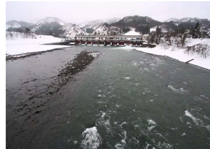
写真 1.1.11 宮中橋から宮中ダムを望む (ケース 2)
