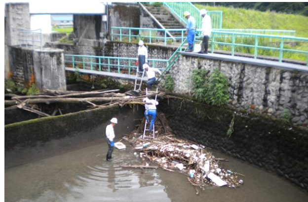
図 2-6 宮中取水ダムにおける流木・塵芥の処理作業（平成 21 年 7 月 22 日撮影）
