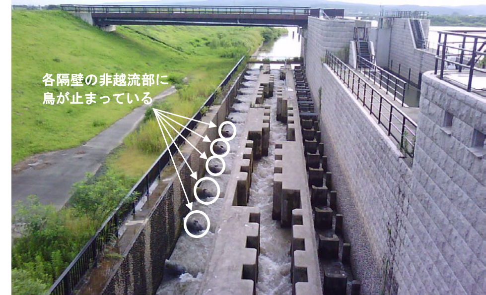
図 2-8 大河津分水工洗堰の魚道
