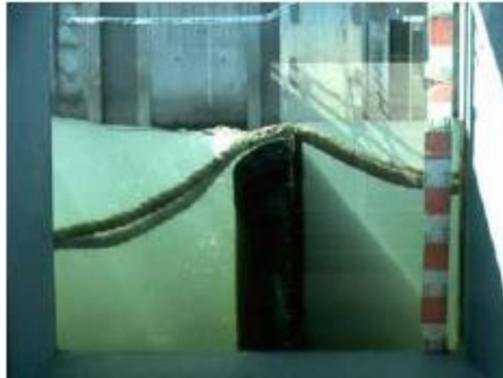
図 2-10 階段式魚道へのロープの設置例
