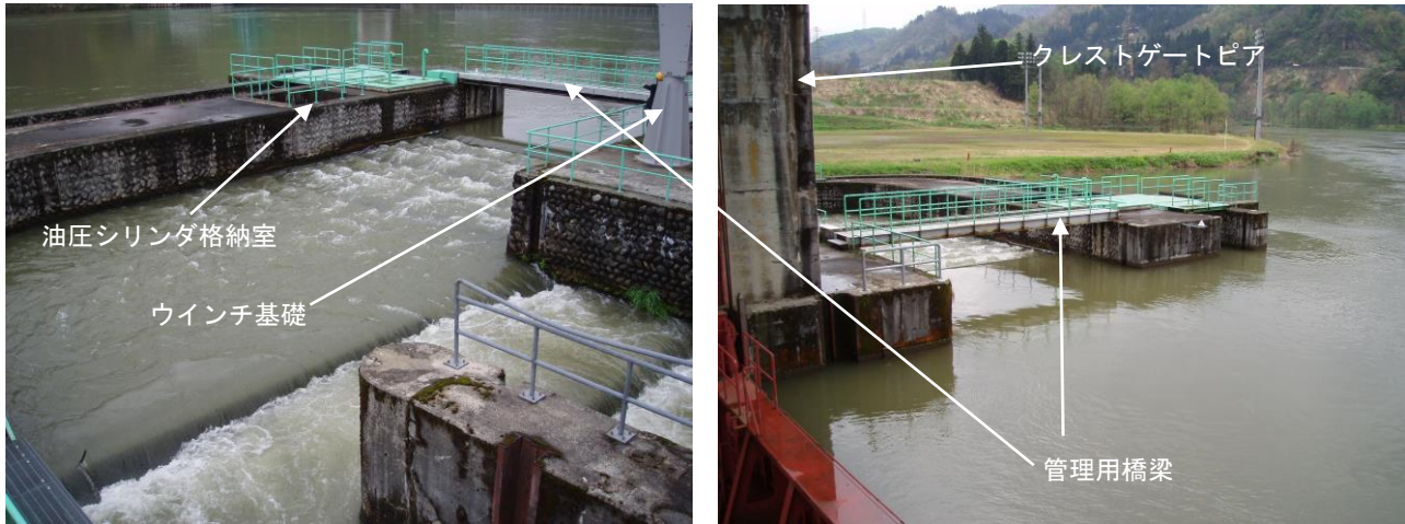
(魚道上部より) (クレストゲート側より)
