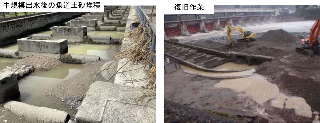
図 1.1.2 中規模出水後の魚道土砂堆積と撤去状況
