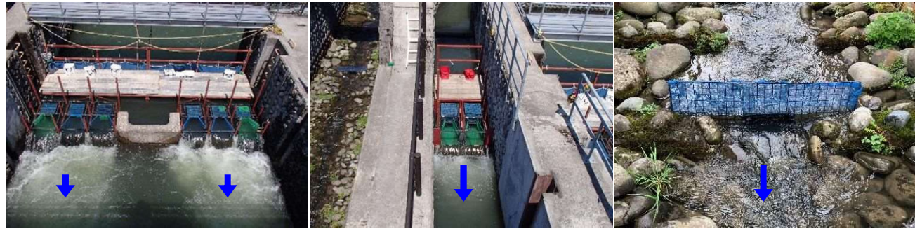
図 2.2 捕獲カゴの設置の状況（左：大型魚道、中央：小型魚道、右：せせらぎ魚道）
