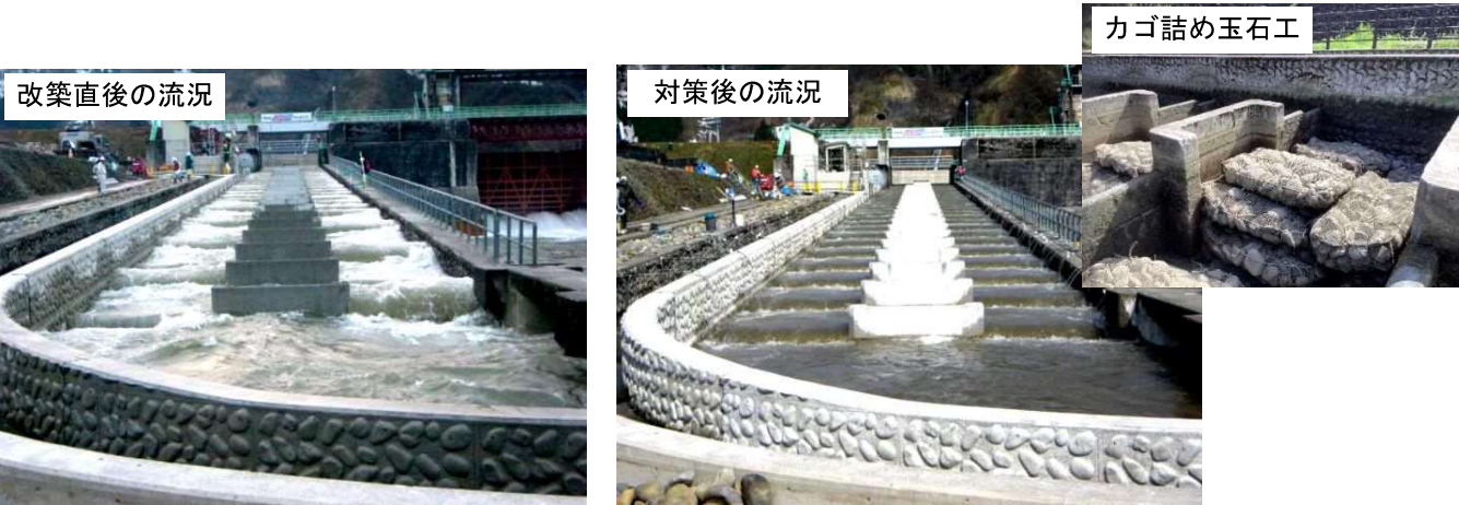
図 1.1.1 流況対策工の有無での流況（横波）の比較
