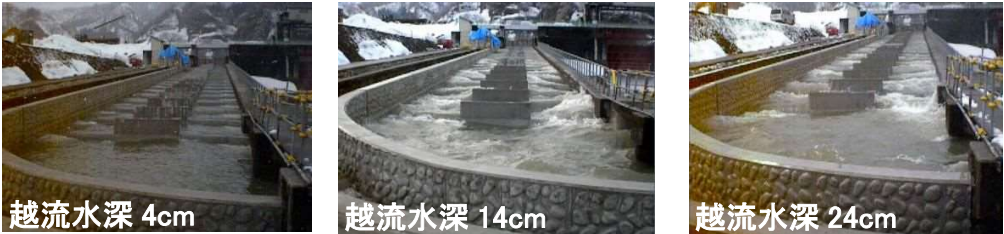
図 1.2.1 魚道完成直後（対策なし）の大型魚道の流況
