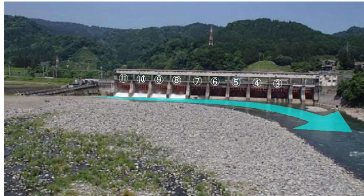
図 4.1.1 ゲート放流状況（60m³/s 程度放流時）
