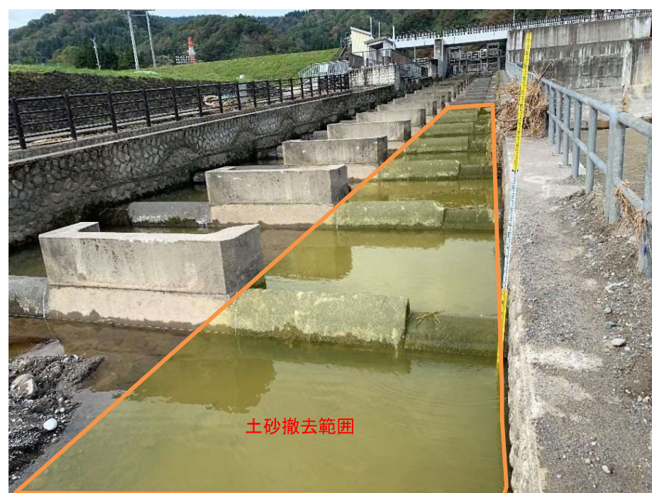
図1.4 魚道折返し部上流方の復旧状況（暫定通水直前）
