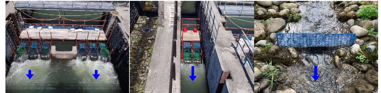
図 4.1.6 捕獲カゴの設置の状況（左：大型魚道 中央：小型魚道 右：せせらぎ魚道）
