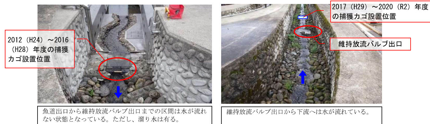
図 4.1.5 捕獲カゴの設置位置と維持放流バルブの出口の状況
