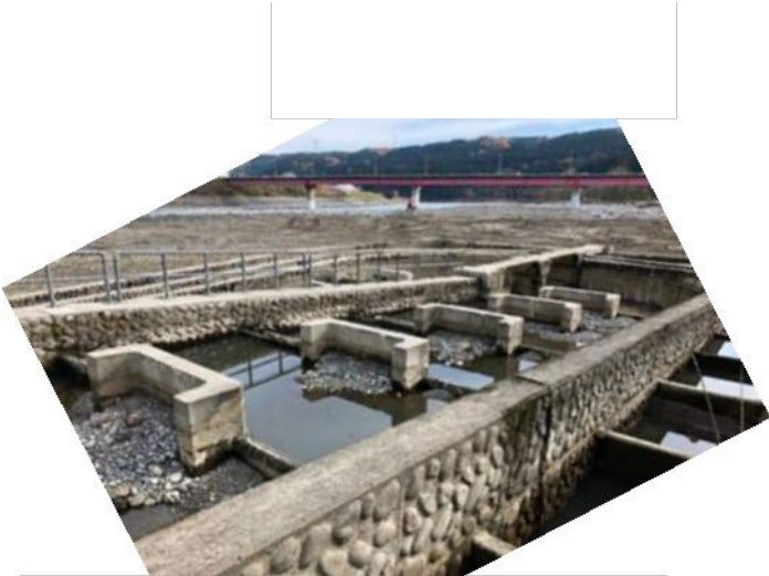
図 1.8 暫定通水前の土砂撤去状況
