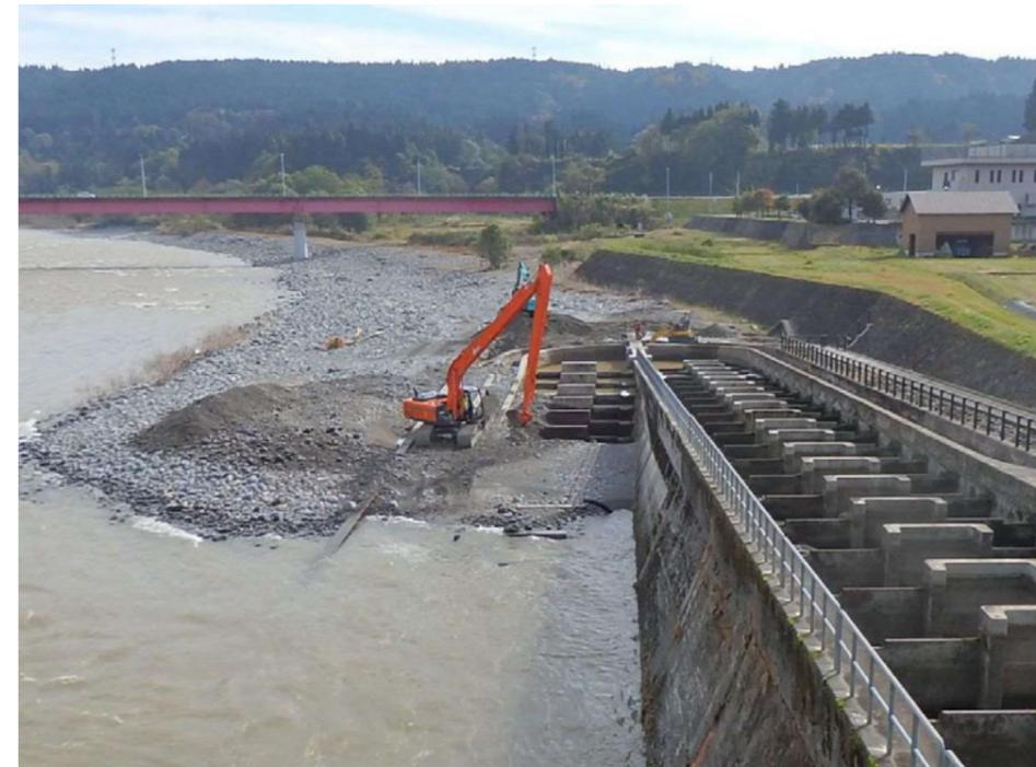
写真4.3 魚道折返し部下流方の復旧作業状況
