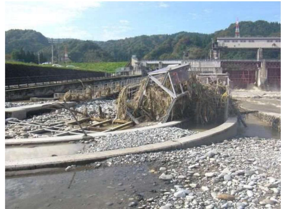
写真3.3 サケ遡上調査用トラップの被災状況（10月26日）
