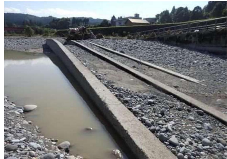
写真3.2 魚道折返し部下流方の被災状況（10月26日）
