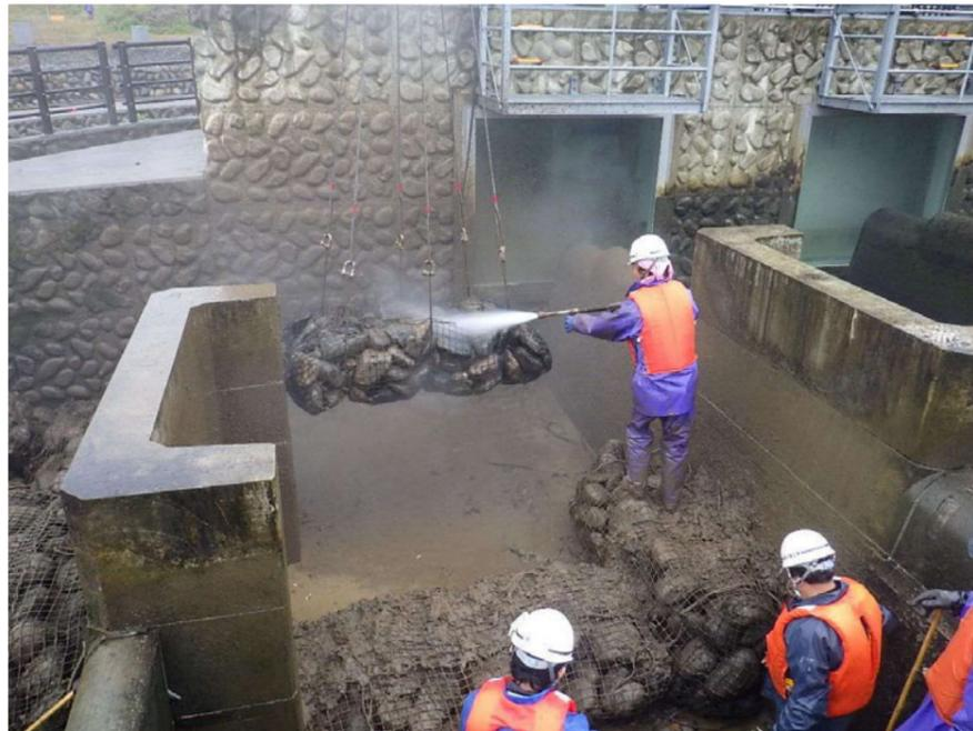
写真2.1 カゴ詰め玉石工の清掃状況
