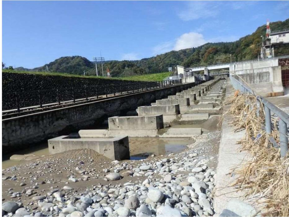
写真3.4 魚道折返し部上流方の被災状況（10月26日）
