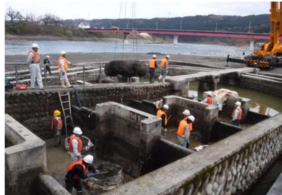
写真2.3 堆積した土砂の撤去作業
