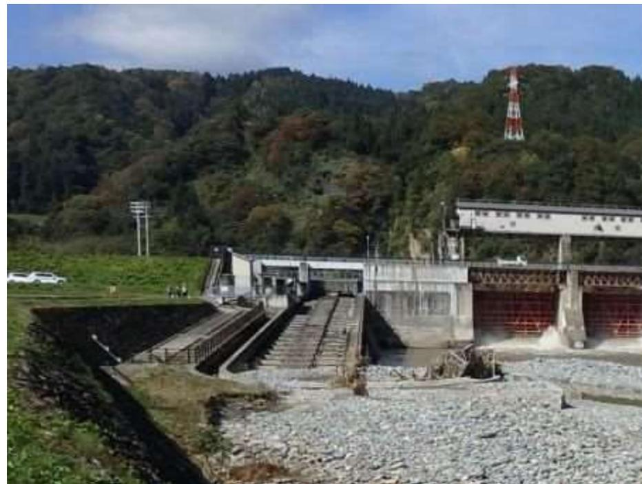
写真3.5 下流からの魚道の被災状況（10月26日）
