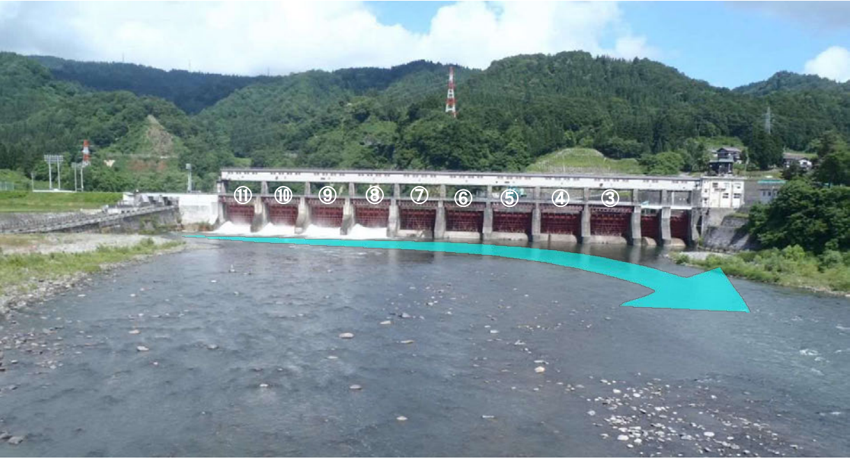
図 3.1.3 ゲート放流状況（60m 3 /s 相当放流時：6 月 1 日～7 月 4 日）
