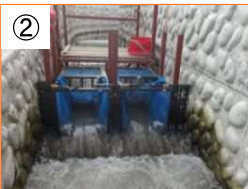
捕獲カゴ設置箇所 （小型魚道）
