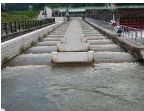
袋詰玉石工による流況確認試験状況
