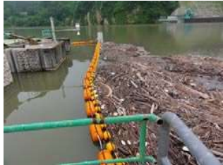
網場によって流木・塵芥の魚道への流入が防がれている様子（平成24年6月25日撮影）
