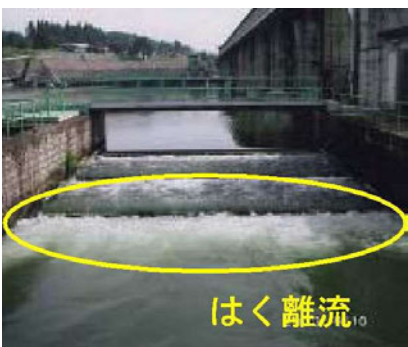
はく離流発生状況（左：3.99m 3 /s 右：2.85m 3 /s）
