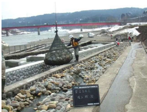
袋詰玉石工による流況確認試験状況
