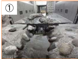
小型捕獲カゴ設置箇所 （せせらぎ魚道）
