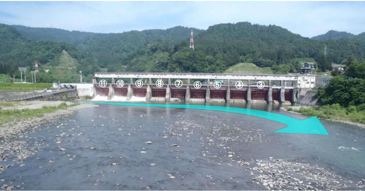
図 3.1.2 ゲート放流状況（40m 3 /s 相当放流時：5 月 26 日～5 月 31 日）
